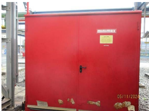
ระบบป้องกันการเกิดเพลิงไหม้โดยใช้คาร์บอนไดออกไซด์บริเวณเครื่องกังหันก๊าซ
