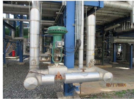
ฉนวนหุ้มเครื่องจักรและอุปกรณ์ที่มีอุณหภูมิสูง
