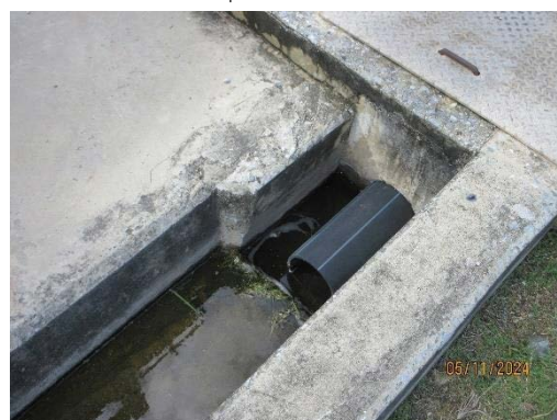
ท่อระบายน้ำฝนปนเปื้อน
