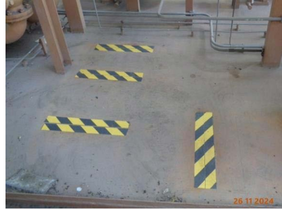
วัสดุกันล้อในบริเวณที่มีการกระเด็นหรือปนเปื้อนน้ำมัน
