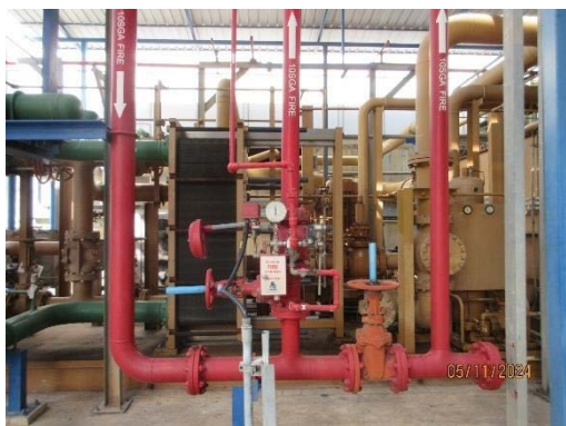
ระบบท่อปล่อยน้ำดับเพลิง บริเวณเครื่องกังหันไอน้ำ
