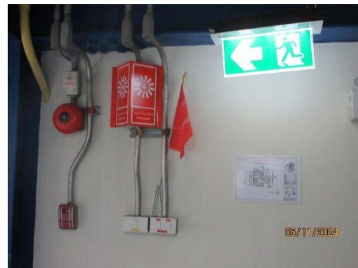
ระบบเตือนภัย สัญญาณเสียง และสัญญาณไฟกะพริบ
