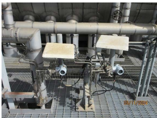
อุปกรณ์วัดระดับและแรงดันไอน้ำของหน่วยผลิตไอน้ำ
