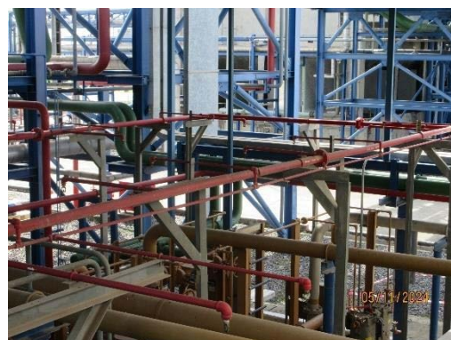
ระบบท่อปล่อยน้ำดับเพลิงบริเวณระบบฉีดน้ำมันหล่อลื่น
