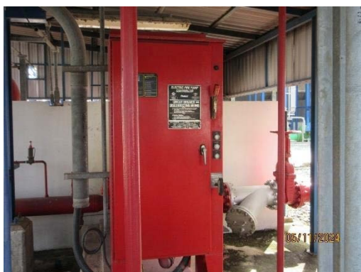
ระบบเครื่องสูบน้ำดับเพลิงหลัก
