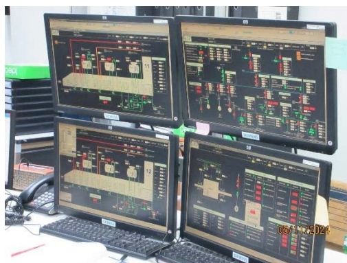
ระบบคอมพิวเตอร์ควบคุมอัตโนมัติ (Distribution Control System ; DCS)
