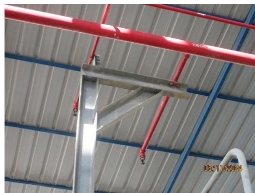
ระบบท่อปล่อยน้ำดับเพลิง บริเวณเครื่องกังหันไอน้ำ
