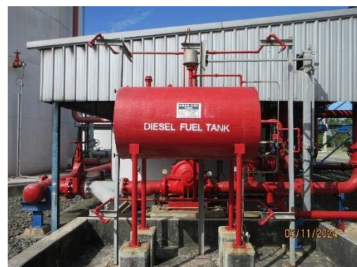
ระบบเครื่องสูบน้ำดับเพลิงสำรอง
