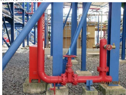
หัวดับเพลิงบริเวณเครื่องผลิตไอน้ำความดันสูง
