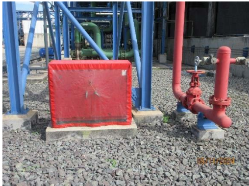
อุปกรณ์ดับเพลิงและหัวฉีดน้ำดับเพลิง
