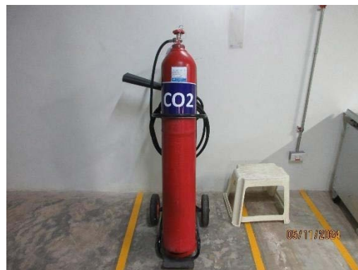
ถังดับเพลิงชนิดคาร์บอนไดออกไซด์ที่ติดตั้งบนรถเข็น
