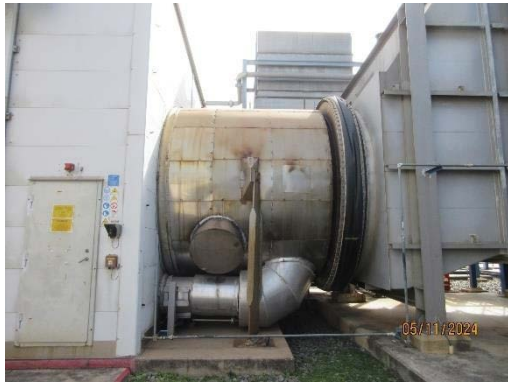
ฉนวนหุ้มเครื่องจักรและอุปกรณ์ที่มีอุณหภูมิสูง
