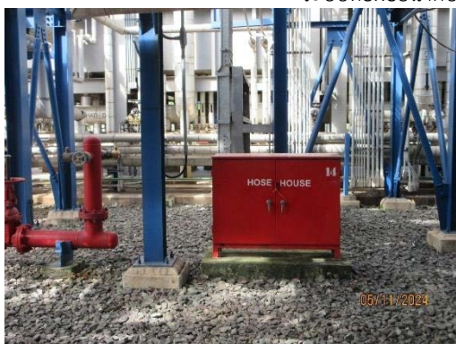
หัวดับเพลิงบริเวณเครื่องผลิตไอน้ำความดันสูง
