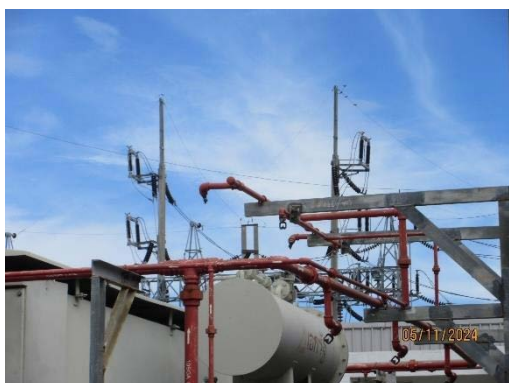
ระบบท่อปล่อยน้ำดับเพลิงบริเวณหม้อแปลงแรงดันไฟฟ้า
