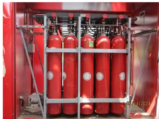
ระบบป้องกันการเกิดเพลิงไหม้โดยใช้คาร์บอนไดออกไซด์บริเวณเครื่องกังหันก๊าซ
